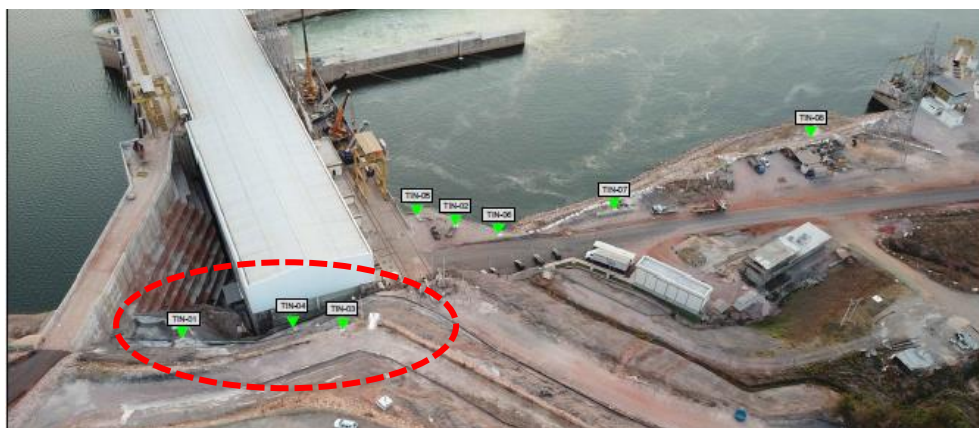
FIGURA 9 – Posição de instalação dos inclinômetros na ombreira direita.
