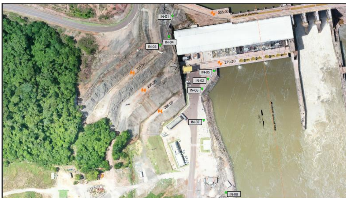
FIGURA 2 – Posição de implantação dos inclinômetros no talude da ombreira direita da UHE Sinop.
